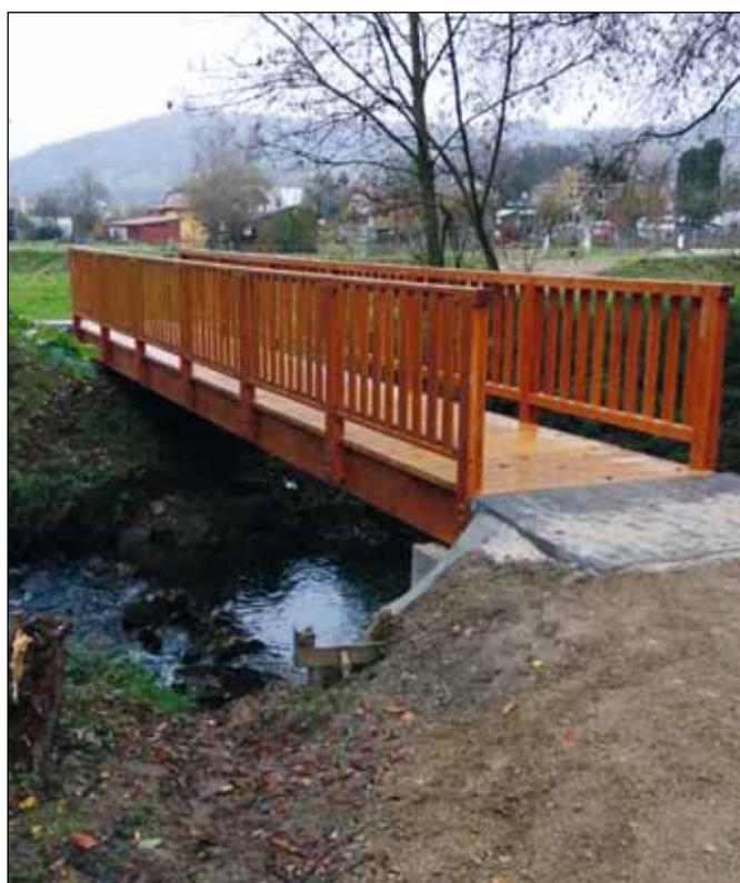
Mostek po úpravě
