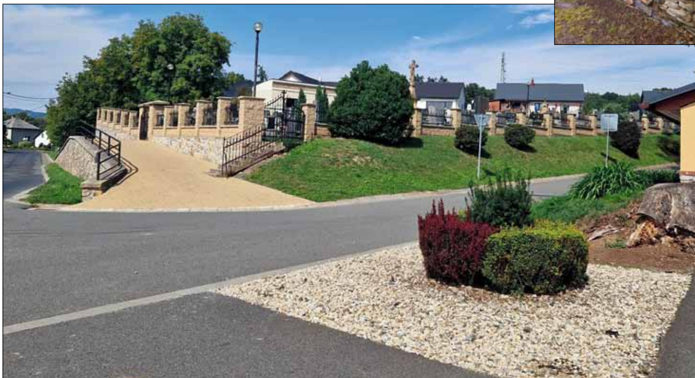
Zídka u hřbitova opravená
